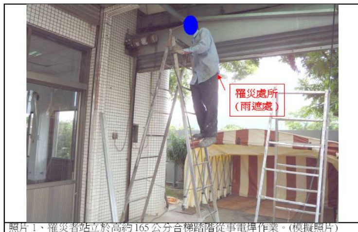
照片 1、罹災者站立於高約 165 公分台梯踏階從事電焊作業。(模擬照片)
