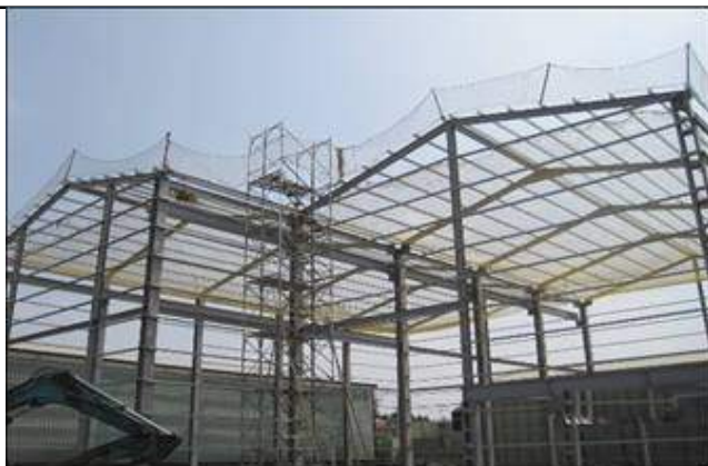
搭設安全上下設備(施工架式內爬梯)
