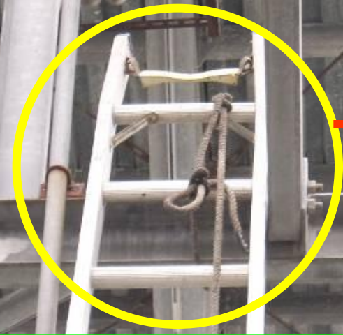
(1)頂端固定梯子防止移動及倒塌
