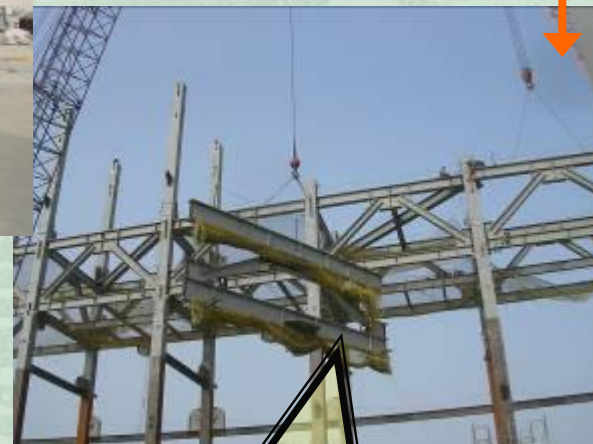
次Truss整組吊裝
