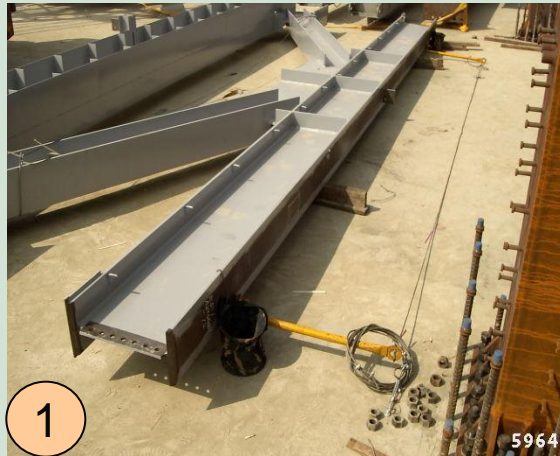
1. 於鋼樑預組C型夾並拉設臨時母索正式母索併同固定於鋼樑上
