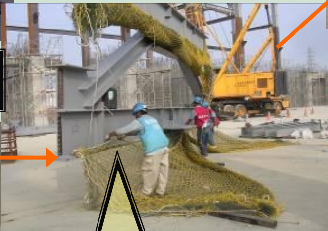
次Truss於地面裝設插架，供人員使用
