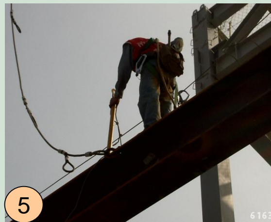
5. 拆除C型夾立柱
