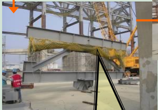
次Truss於地面裝設C型夾及母索
