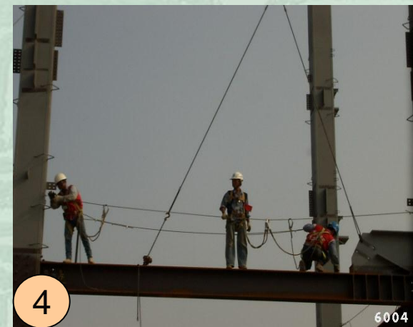
6. 正式母索與鋼柱連結並以緊張器將母索拉緊
