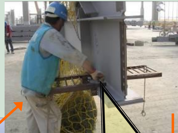
次Truss於地面裝設插架，供人員使用
