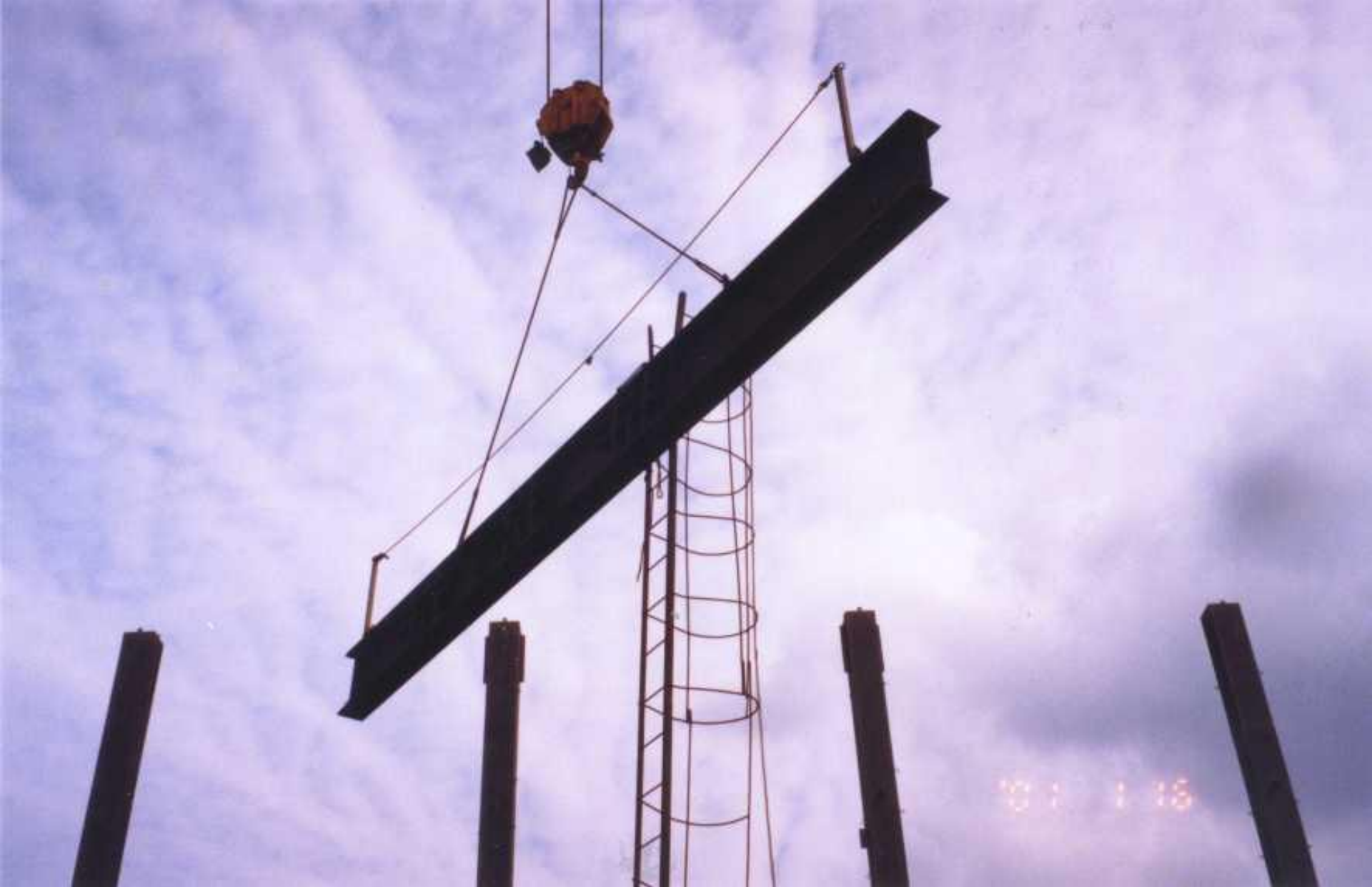
鋼樑上預裝杆柱、安全母索與臨時護籠鐵爬梯
