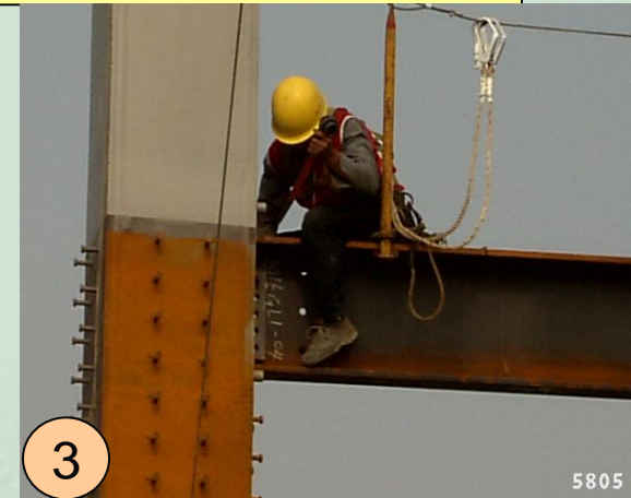
3. 鋼樑與鋼柱連結螺絲鎖緊
