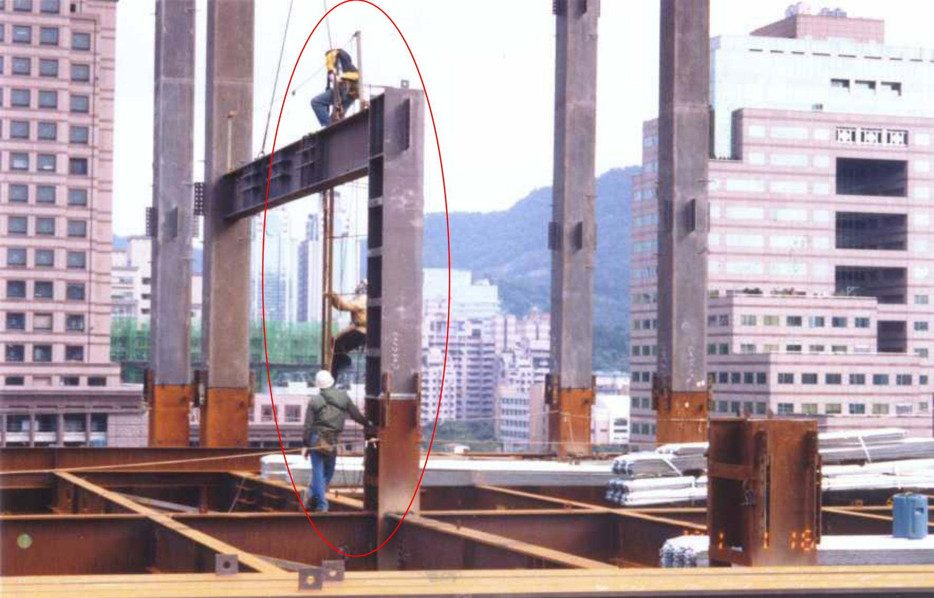
鋼樑安裝人員佩帶捲揚自鎖式防墜器爬上臨時護籠鐵爬梯
