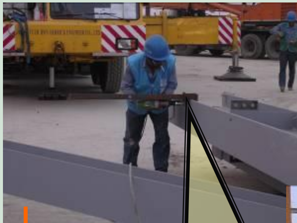
次Truss於地面裝設C型夾及母索
